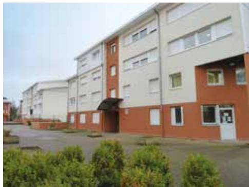
Résidence du Madrillet - St-Etienne-du-Rouvray
